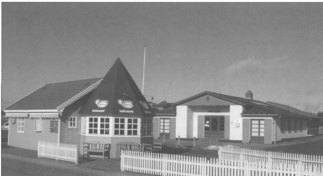
Den sekskantede kiosk er bygget hvor den gamle, lidt mindre lå. Huset bagved er den tilbygning, som Agnes Sillasen fik bygget i 1932, nok fornyet i et vist omfang. Det var her de første vandrere samme år fik tag over hovedet. Kiosken er forlængst solgt fra vandrehjemmet. Foto: HP, feb. 2005.
